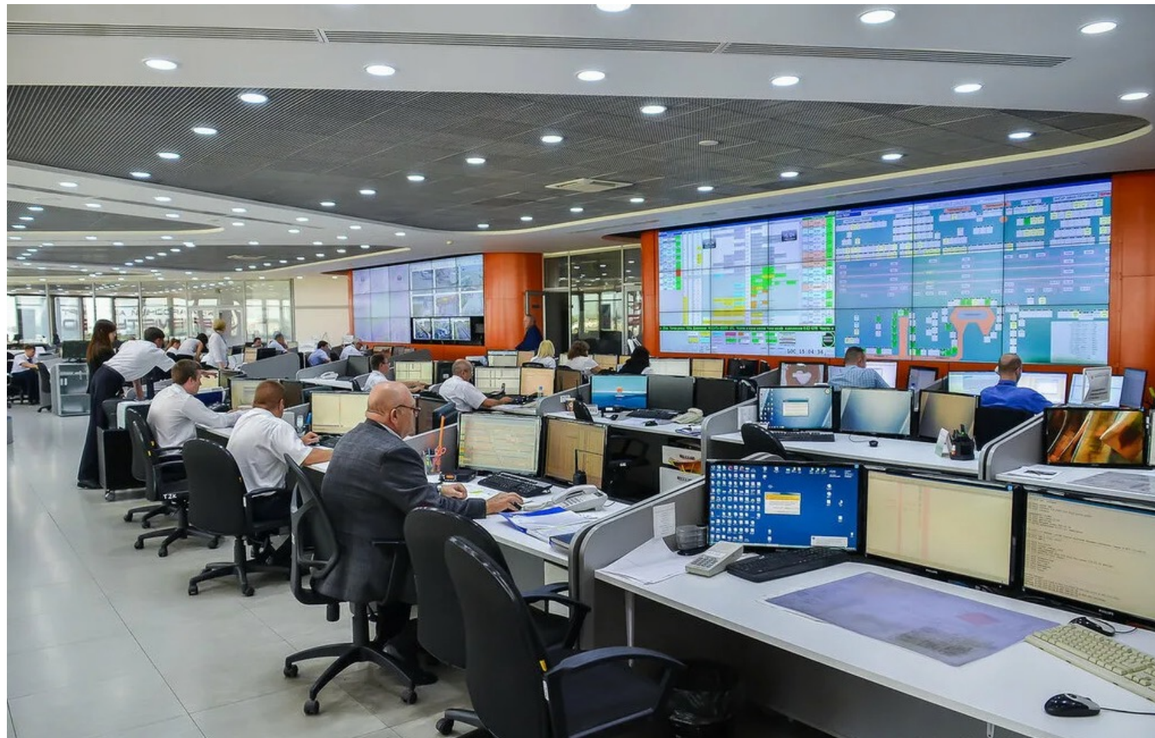
Центр Управления Аэропортом
